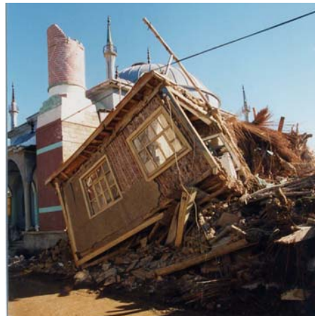
Abb. 11. Fachwerk mit Ziegelsteinfüllung, linker Bildrand umgekipptes Minarett
