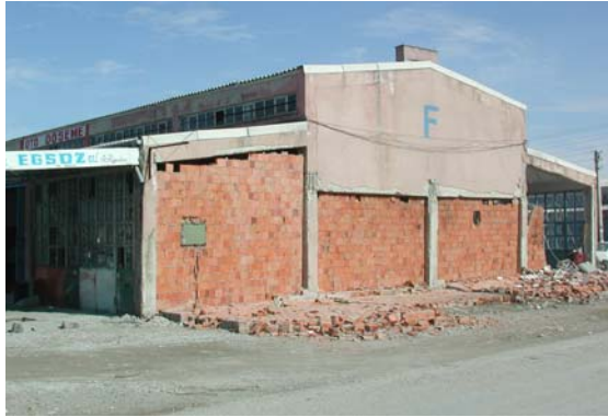
Abb. 8. Geschädigte Stahlbetonhalle
