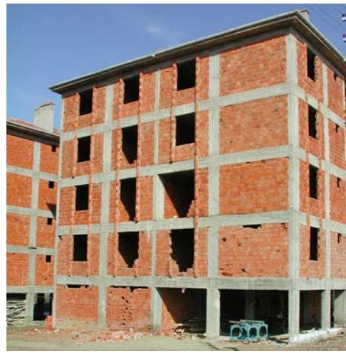
Abb. 13. Instrumentiertes Gebäude, Rohbauphase 2
