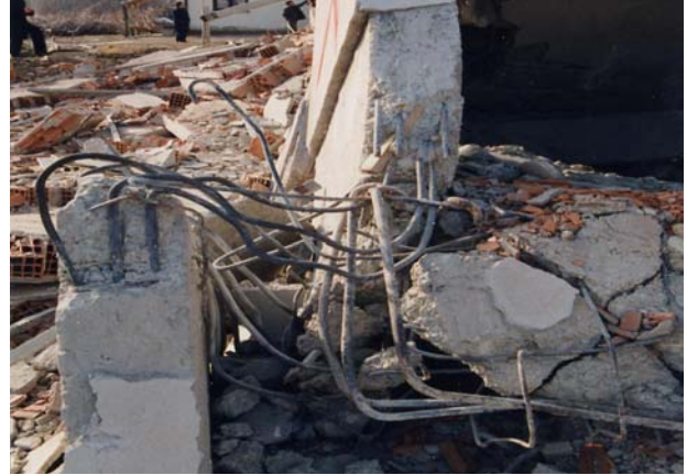
Abb. 3. Detail zu Abb. 2, Anschluß Riegel - Wand
