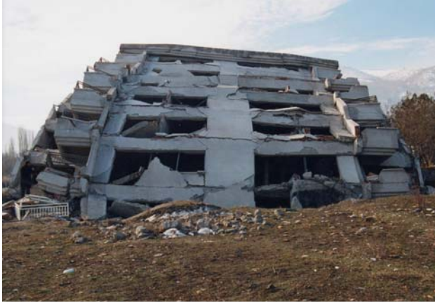
Abb. 2. Totalschaden eines 8-geschossigen Wohnhauses
