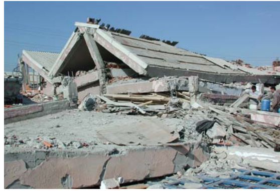
Abb. 9. Eingestürzte Stahlbetonhalle
