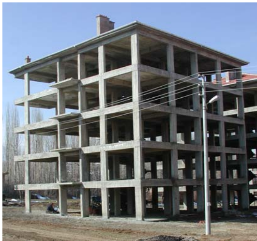
Abb. 12. Instrumentiertes Gebäude, Rohbauphase 1
