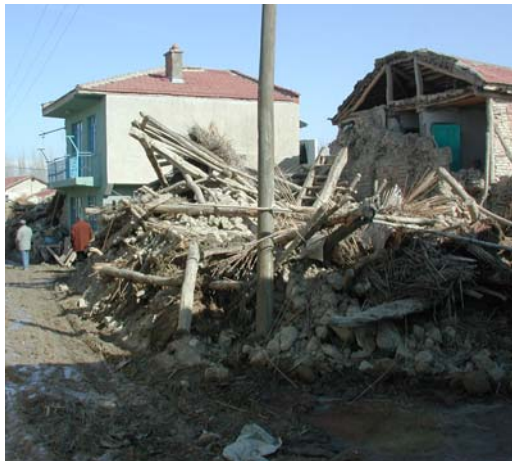
Abb. 10. Eingestürzte traditionelle Bauweise vor jüngerem Gebäude in Eber
