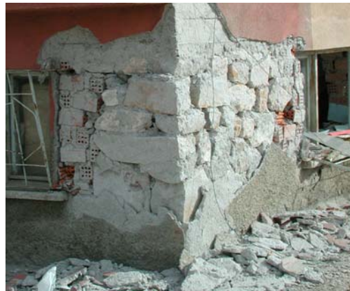
Abb. 7. Detail aus Abb. 6, Kombination Bruchsteinmauerwerk mit Hohlziegeln
