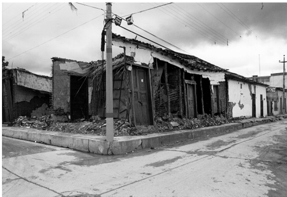
Bild 42. „Bajareque“ - Bauweise mit typischen Schadensmustern
