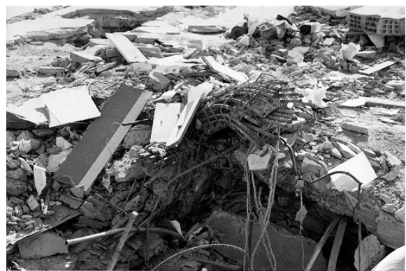
Bild 22. Trümmerberg mit erkennbaren Bewehrungsdetails.
