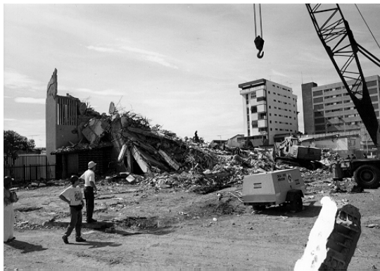
Bild 21. Aufräumungsarbeiten (kaum geschädigte Neubauten im Hintergrund)
