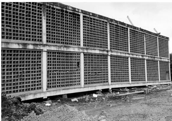
Bild 27. Seitenansicht vom eingestürzten Erdgeschoß
