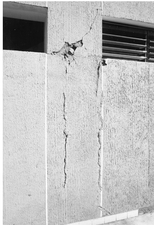
Bild 17. Versagen infolge short-column Effekt („kurze“ Stütze)
