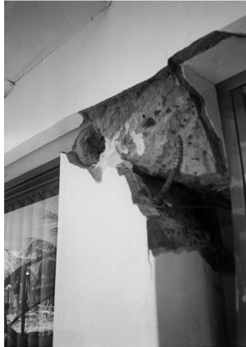
Bild 19. Schubversagen Stütze
