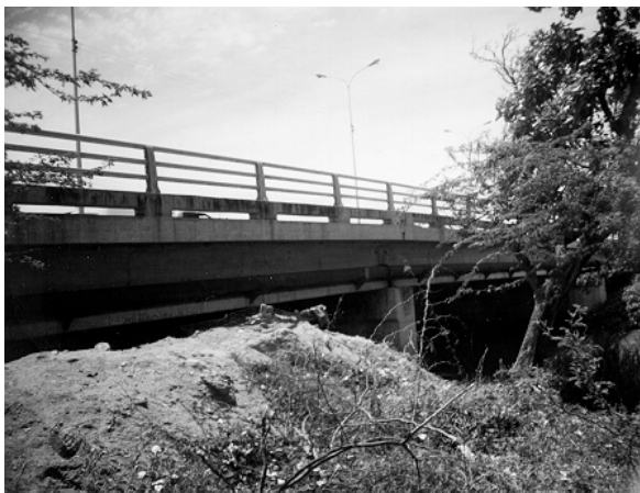
Bild 54. Brücke in Cumana: Ansicht
