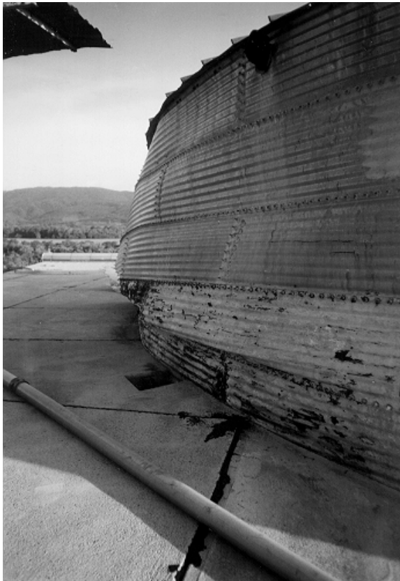
Bild 52. Tank mit Beulerscheinung
