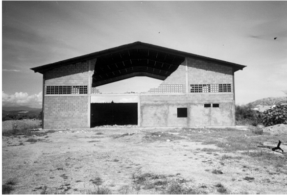
Bild 43. Vorderansicht mit Giebelversagen
