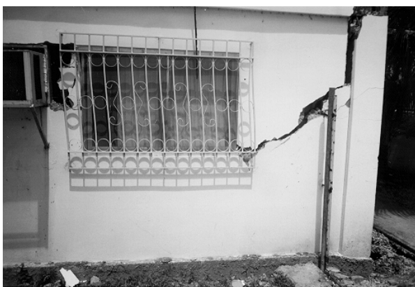
Bild 20. Schubversagen Seitenansicht Erdgeschoß
