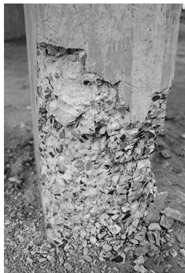
Bild 15. Versagen Detail Stütze
