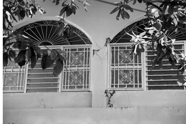
Bild 35. Detail Diagonalrisse über Bogen/ Stütze
