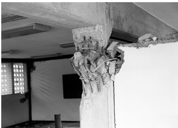
Bild 29. Detail Stützenversagen (Ausknicken der Bewehrung)
