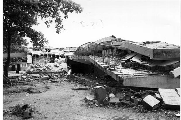
Bild 32. Ansicht mit kollabierten Bereich
