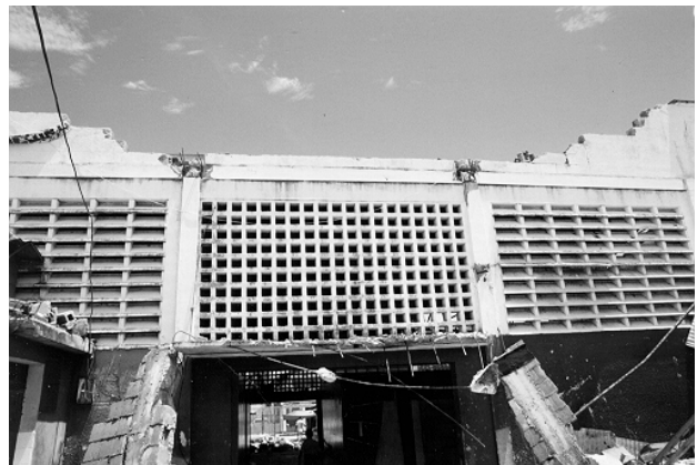
Bild 45. Vorderansicht der geschädigten Halle
