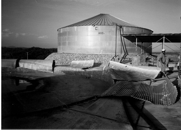
Bild 50. Tank im Hintergrund (leer) ohne größeren Schaden, im Vordergrund Versagen eines gefüllten Tanks
