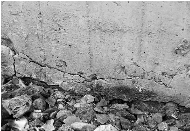
Bild 48. Rißbildung an Basis
