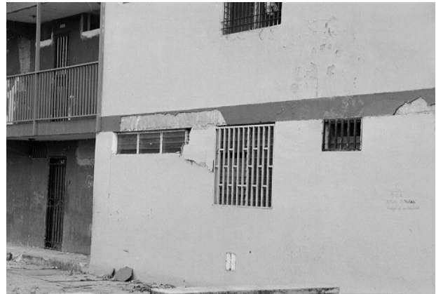
Bild 24. Detail Versagen im Öffnungsbereich
