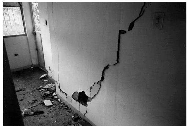
Bild 26. Rißverlauf in Wandanschluß zur Außenwand mit Fenster.
