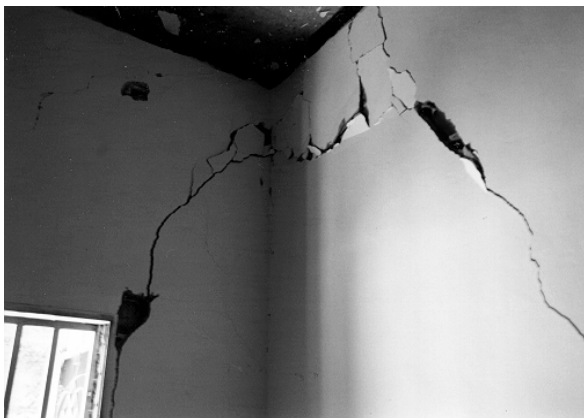
Bild 25. Diagonalriß in Innenwand.
