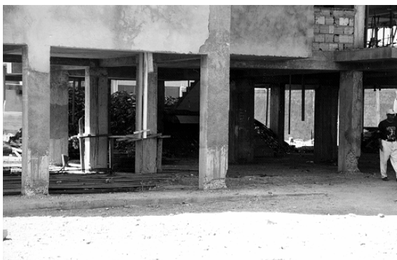
Bild 14. Ansicht Stützen Erdgeschoß
