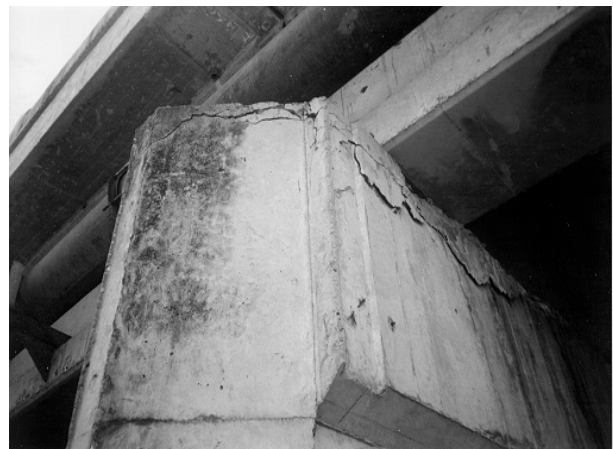
Bild 55. Auflagerverschiebung
