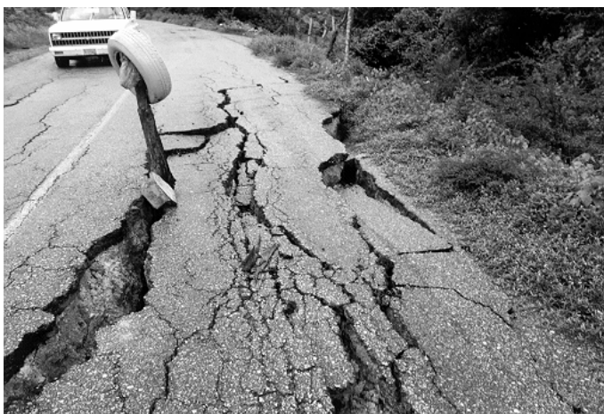
Bild 58. Typischer Grundbruch
