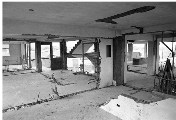
Bild 13. Versagen Trennwand mit Stütze
