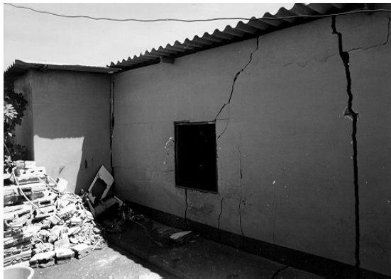
Bild 40. Seitenansicht Haus mit eingefaßtem Mauerwerk
