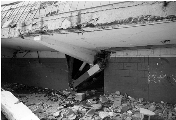
Bild 33. Detail Stützenversagen
