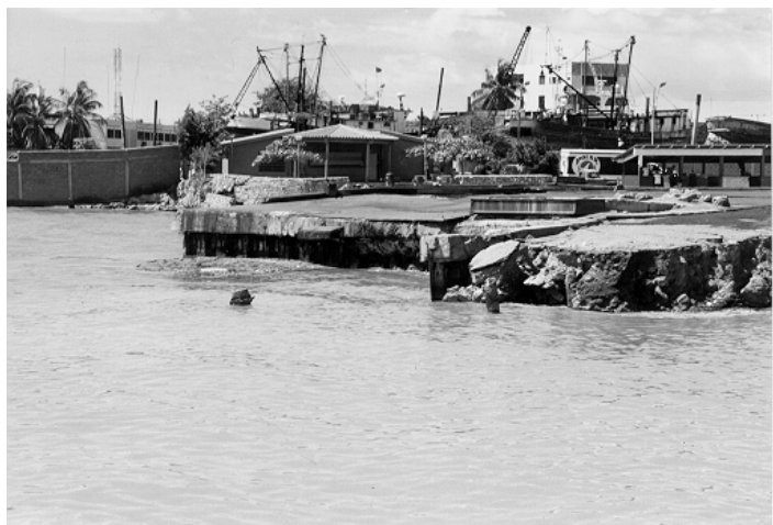
Bild 57. Detail lokaler Einsturz Fahrbahndecke
