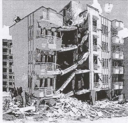
Bild 3: Eingestürztes Wohnhaus einer Neubausiedlung im südlichen Ceyhan (mit Mauerwerk ausgefachte Stahlbetonrahmen).
