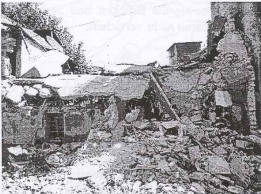
Bild 2: Eingestürztes traditionelles Steinhaus im Stadtzentrum von Adana.
