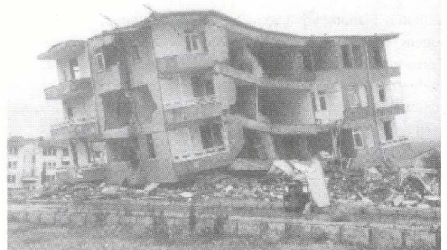
Totalversagen eines viergeschossigen Wohngebäudes in Deringe (Izmit).
