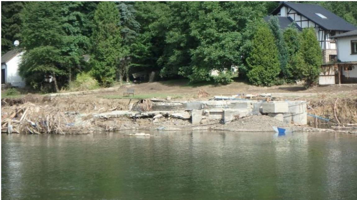
Strukturelle Schäden durch **Anprall von Treibgut** in Schuld (Schadensgrad D4)
